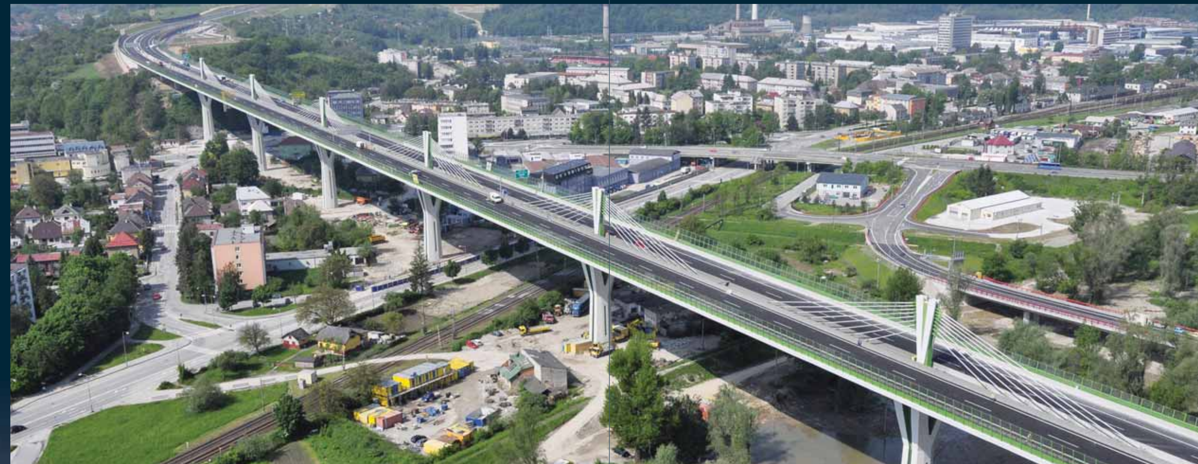
Most 206 - estakáda ponad Považskú Bystricu Bridge - Structure 206 - Flyover over the town of Považská Bystrica
