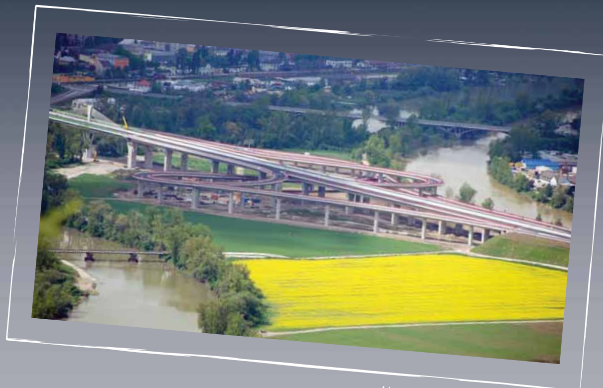
Mostné objekty križovatky Centrum Bridges of the "Centrum" Interchange
