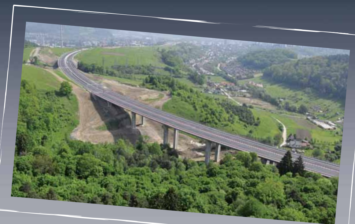
Most 204 - zhotovený technológiou montáže prefabrikovaných prvkov Bridge - Structure 204 - constructed by the precast members erection method
