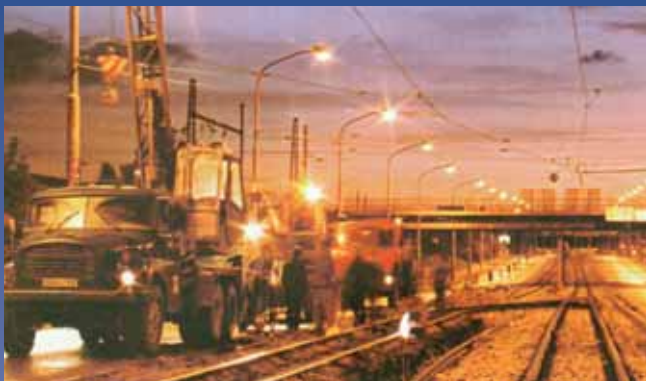
REKONŠTRUKCIA ELEKTRICHOVEJ TRATE TOMAŠÍKOVA – JURAJOV DVOR
