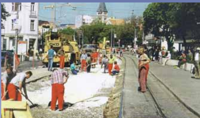
REKONŠTRUKCIA ELEKTRICHOVEJ TRATE NÁM. Ľ. ŠTÚRA – NÁM. SNP
