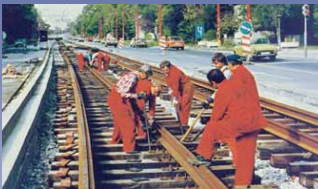
REKONŠTRUKCIA ELEKTRICHOVEJ TRATE TUNEL – NOVÝ MOST
