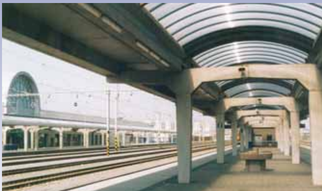
DOSTAVBA ŽELEZNIČNEJ TRATE BRATISLAVA-ÚNS – PETRŽALKA 2
