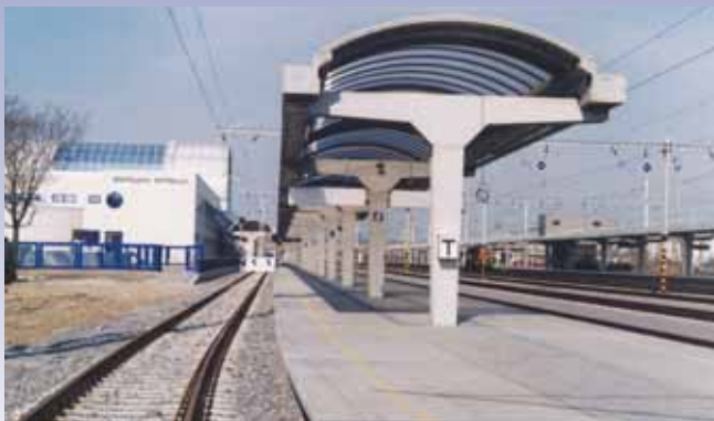
DOSTAVBA ŽELEZNIČNEJ TRATE BRATISLAVA-ÚNS – PETRŽALKA 1
